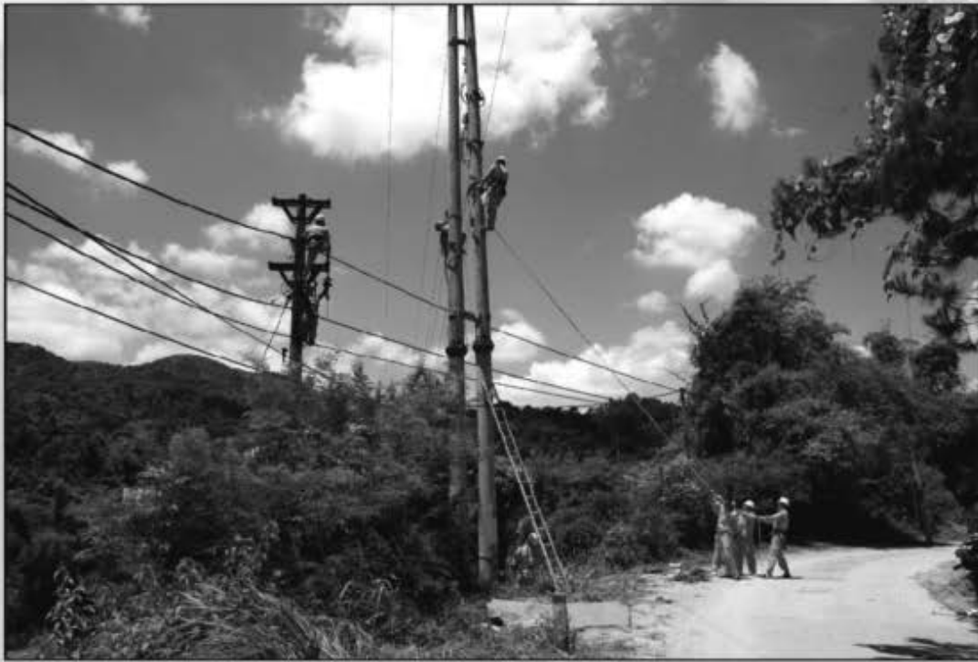
Đường điện mới
